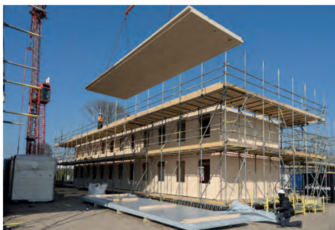
De drie woongebouwen in Waalwijk zijn geheel in CLT opgebouwd.
