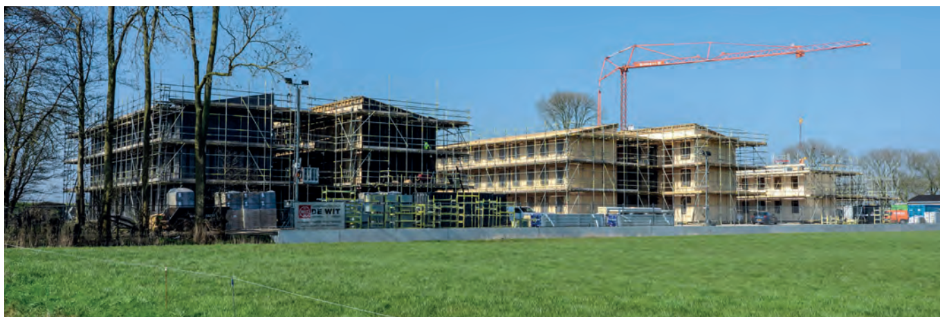
De drie woongebouwen in aanbouw, maart 2024.
